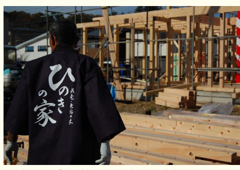
工務店からなる「棟梁会」。無垢の木を取り扱う腕に差が出ます。
